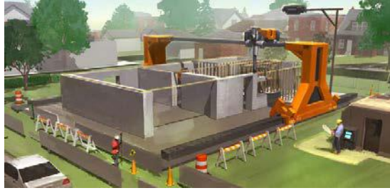
Şekil 11. 3 boyutlu beton yazıcılar ile konutun inşa edilmesine örnek (Khoshnevis, 2015)
